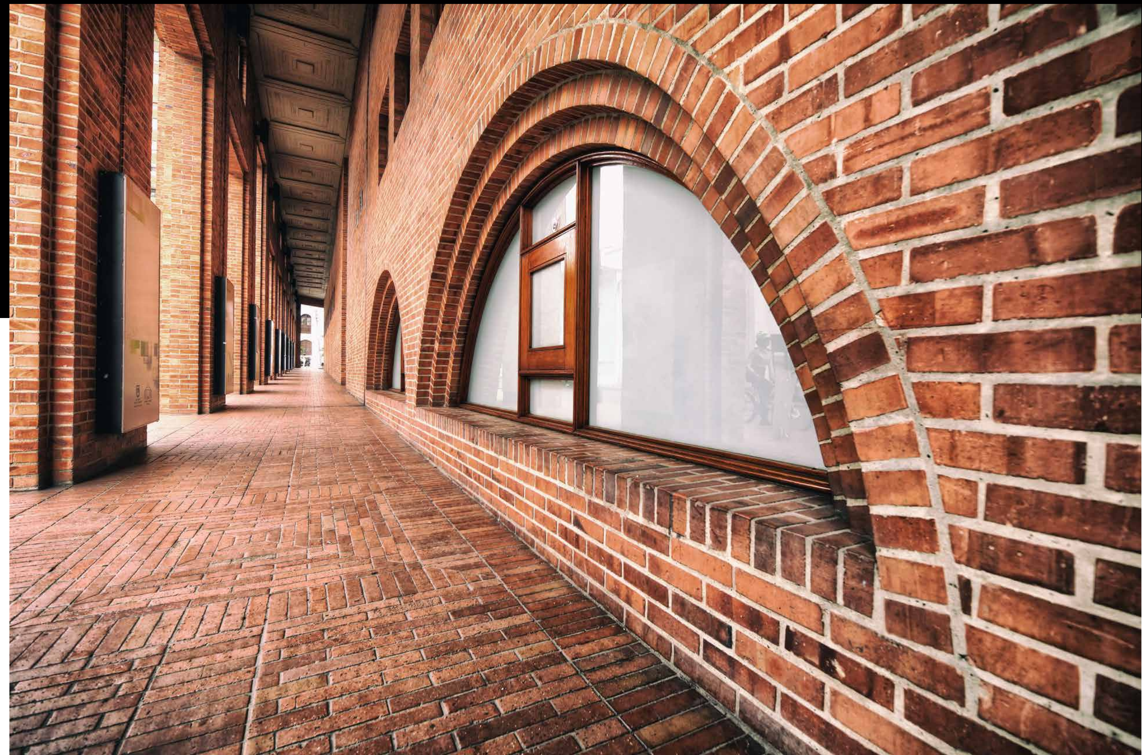
Arcos y Columnas, Edificio del Centro Cultural de Cali Valle del Cauca, Colombia.
